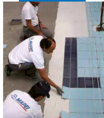
Posa di rivestimento ceramico su Mapelastic
