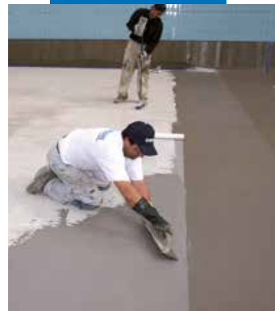
Impermeabilizzazione di una piscina con Mapelastic
